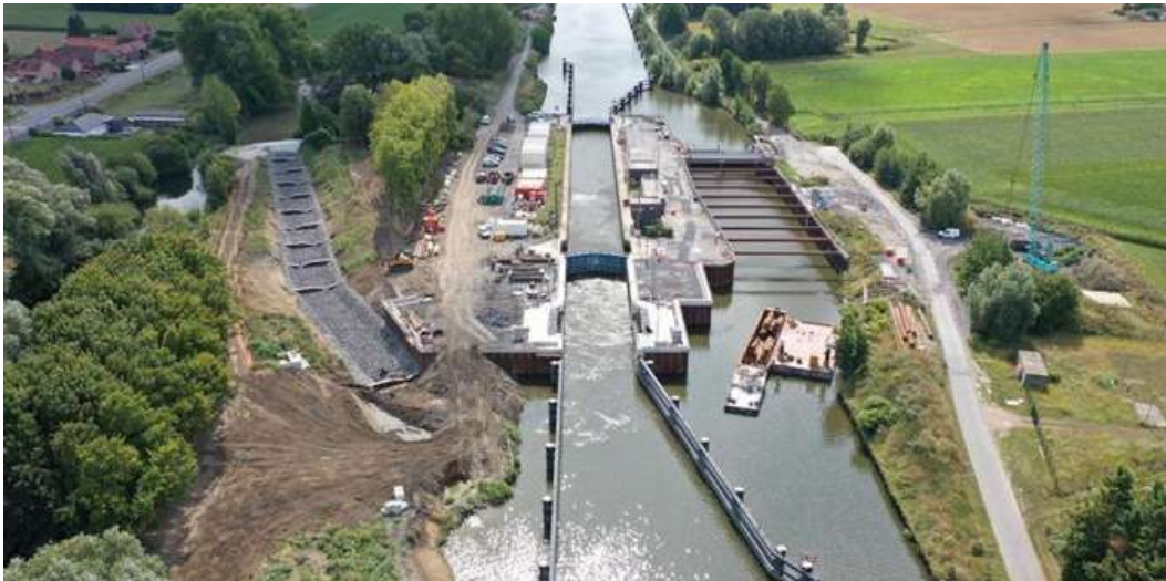
Verlenging van de sluis van Quesnoy-sur-Deûle in 2025 (@INGEO)
