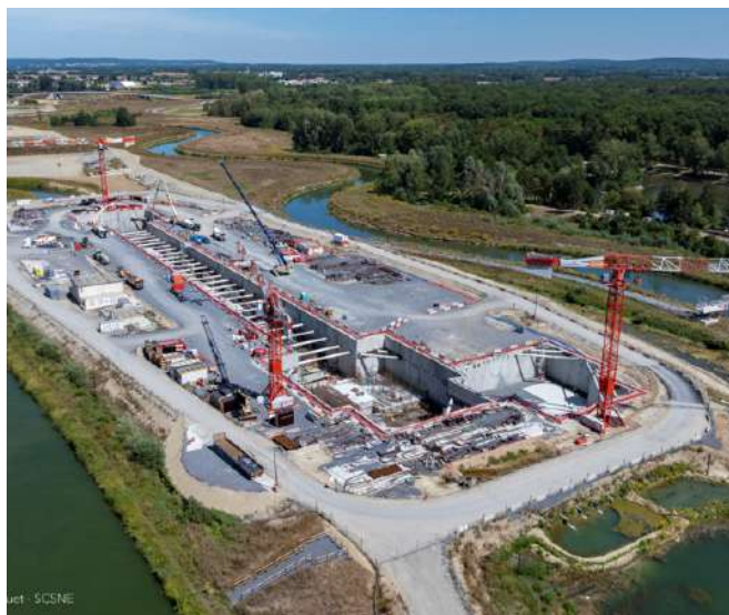
Werk van de sluis in Montmacq-Cambronne-lès-Ribécourt op de Oise ( ©SCSNE-Odile et Jean-Christophe Hecquet)
