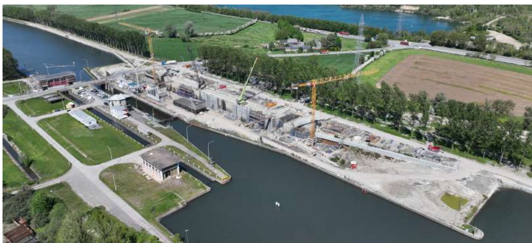
Modernisering van het sluiscomplex in Obourg op het canal du Centre in Wallonië (©SPW)
