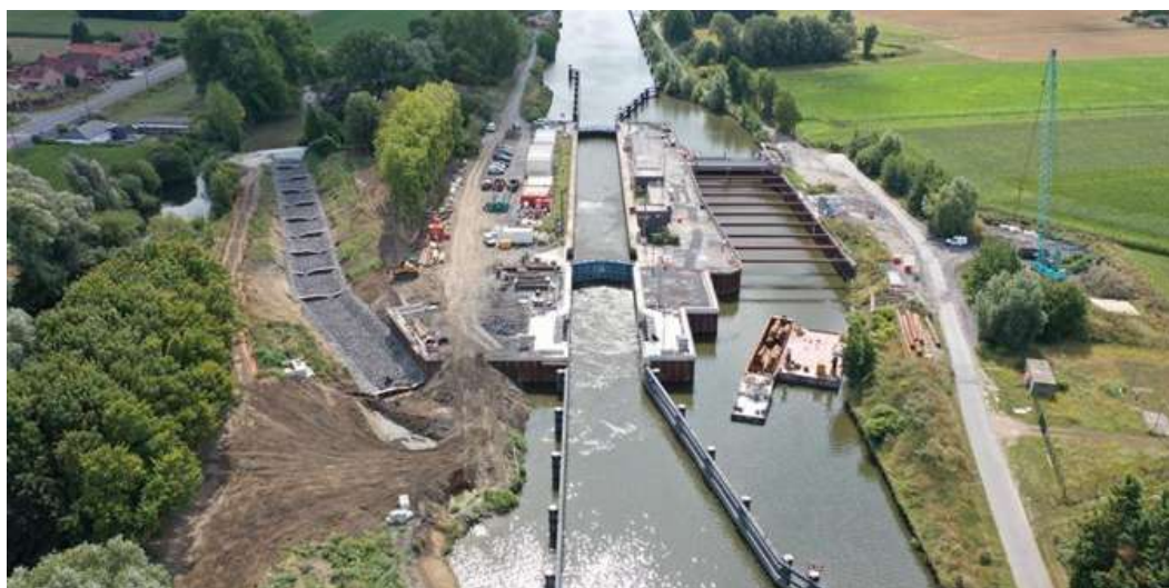
Allongement de l'écluse de Quesnoy-sur-Deûle en 2025 (Crédit photo : @INGEO)
