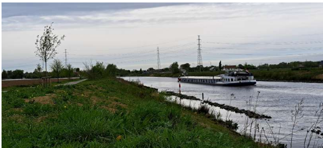
Les nouvelles berges de la Lys à Zulte (Crédit photo : ©De Vlaamse Waterweg nv)
