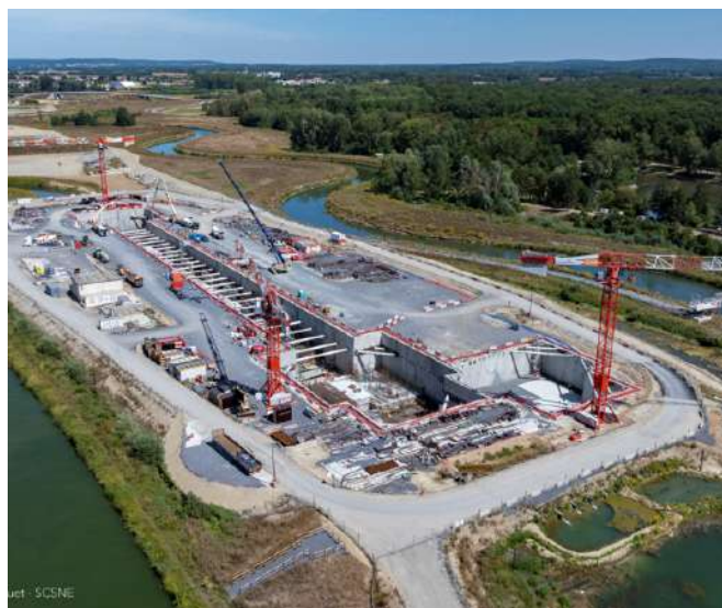
Chantier de l'écluse de Montmacq-Cambronne-lès-Ribécourt dans l'Oise (Crédit photo : ©SCSNE-Odile et Jean-Christophe Hecquet)
