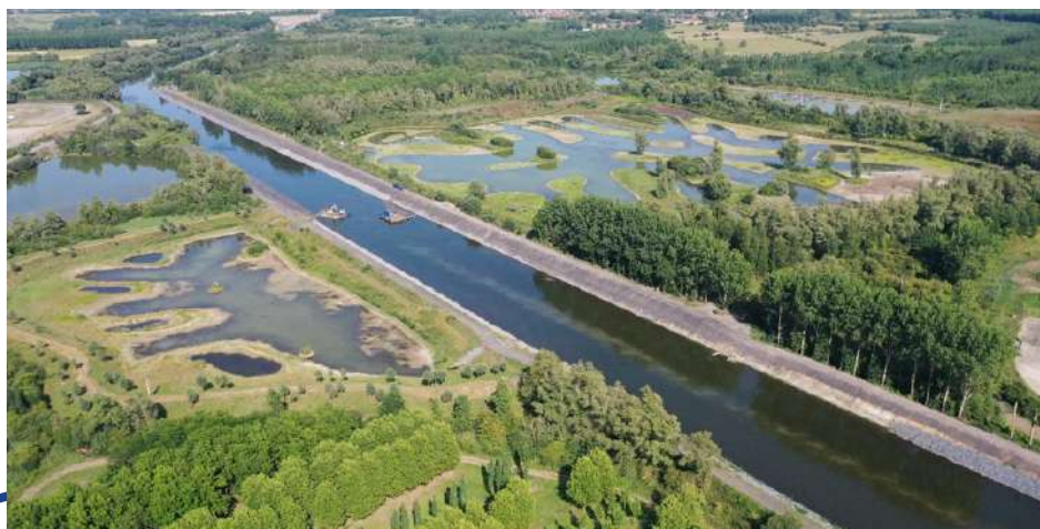
Réouverture du Canal Condé-Pommeroeul et zones de compensation environnementale (Crédit photo : ©VNF Ph. Houzé)
