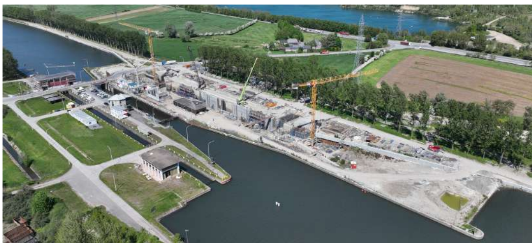
Modernisation du site éclusier d'Obourg sur le canal du Centre, en Wallonie (Crédit photo : ©SPW)
