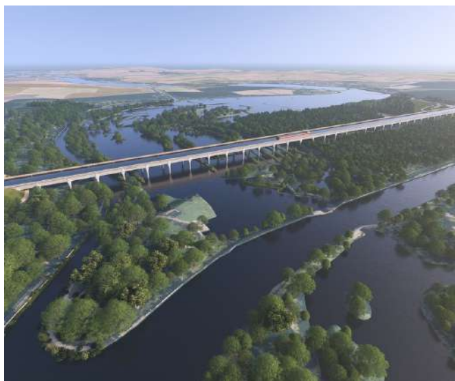
Le Pont-Canal de la Somme (Crédit photo : ©Canalieu Lavigne Chéron architectes)
