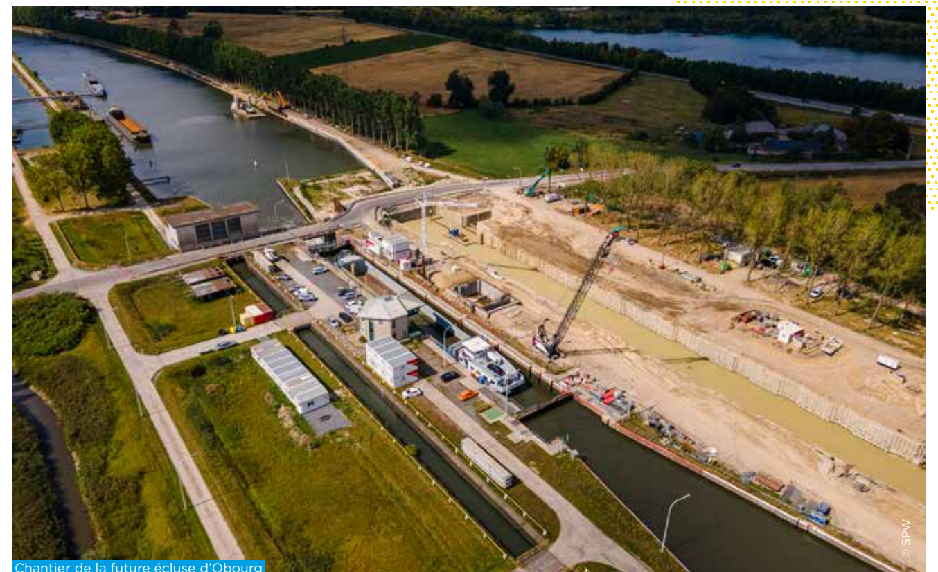
Chantier de la future écluse d'Obourg
