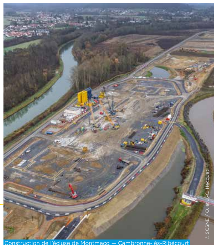
Construction de l'écluse de Montmacq — Cambronne-lès-Ribécourt
