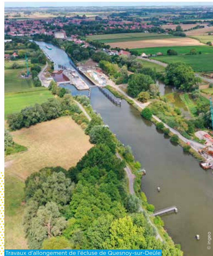
Travaux d'allongement de l'écluse de Quesnoy-sur-Deûle
