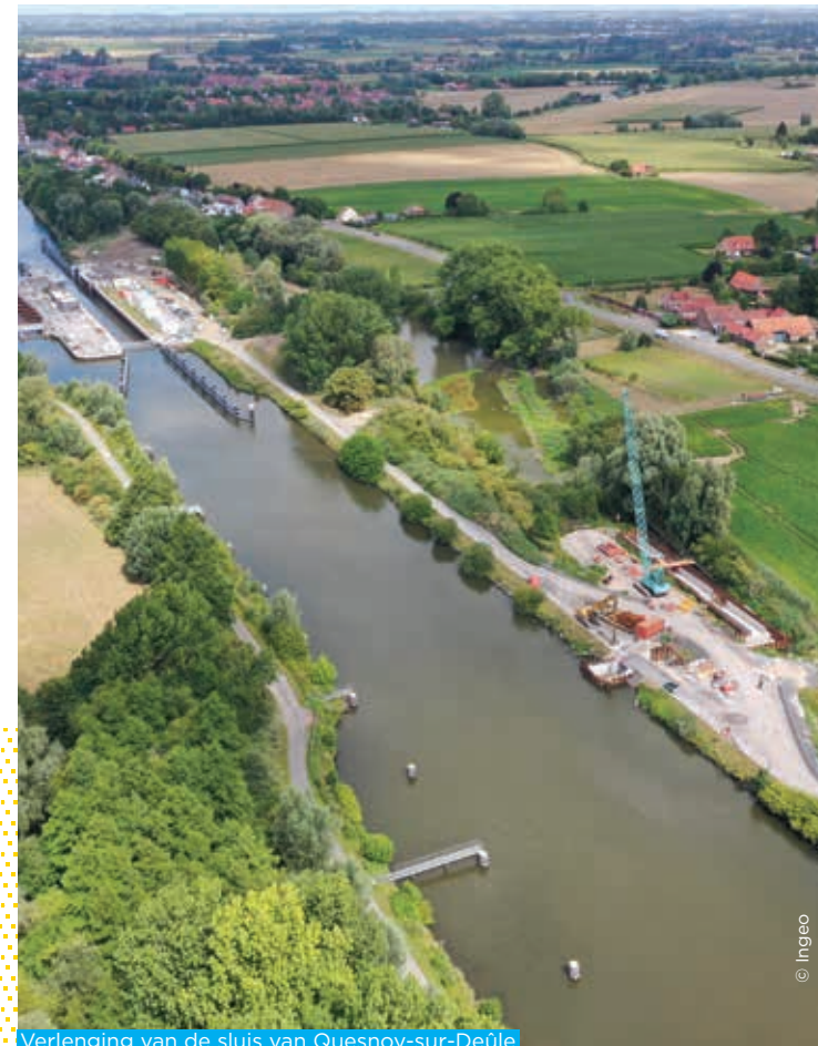
Verlenging van de sluis van Quesnoy-sur-Deûle
