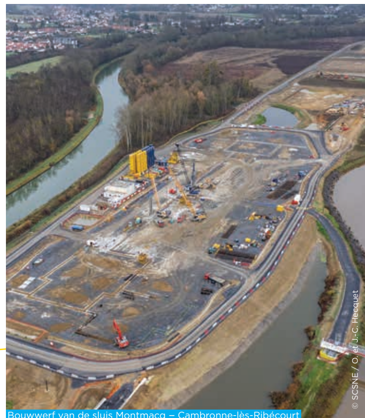
Bouwwerk van de sluis Montmacq – Cambronne-lès-Ribécourt
