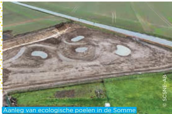
Aanleg van ecologische poelen in de Somme
