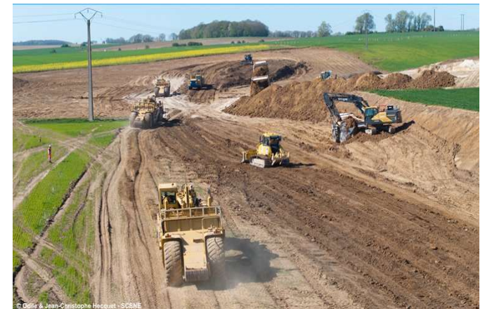
Terrassement de l'écluse d'Oisy-le-Verger lock (CSNE) Juin 2026
