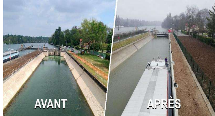
Modernisation de la deuxième écluse La Cave (Seine) (2023 – crédits : @VNF)
