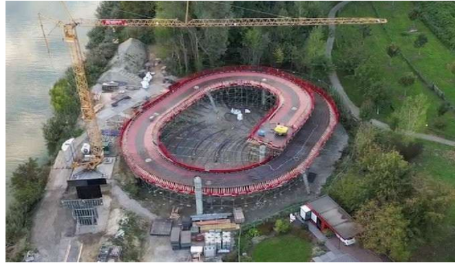
Chantier du pont Ingelmunster (Flandres)
