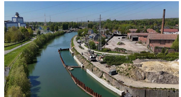
Travaux de développement sur le canal de Nimy-Blaton (Wallonie)
