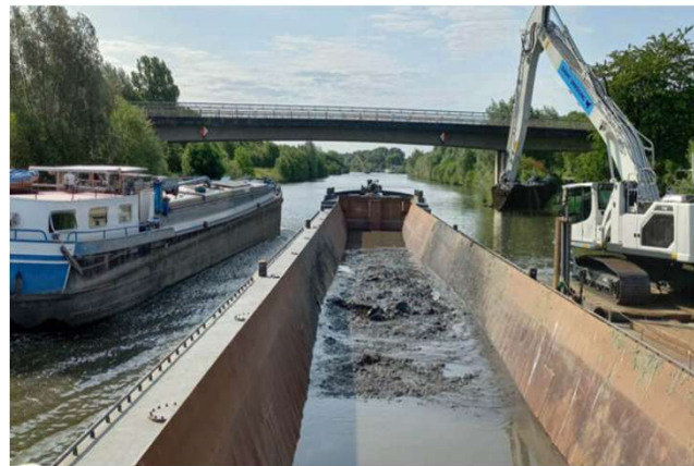
Travaux de recalibrage sur la Lys, rivière commune
