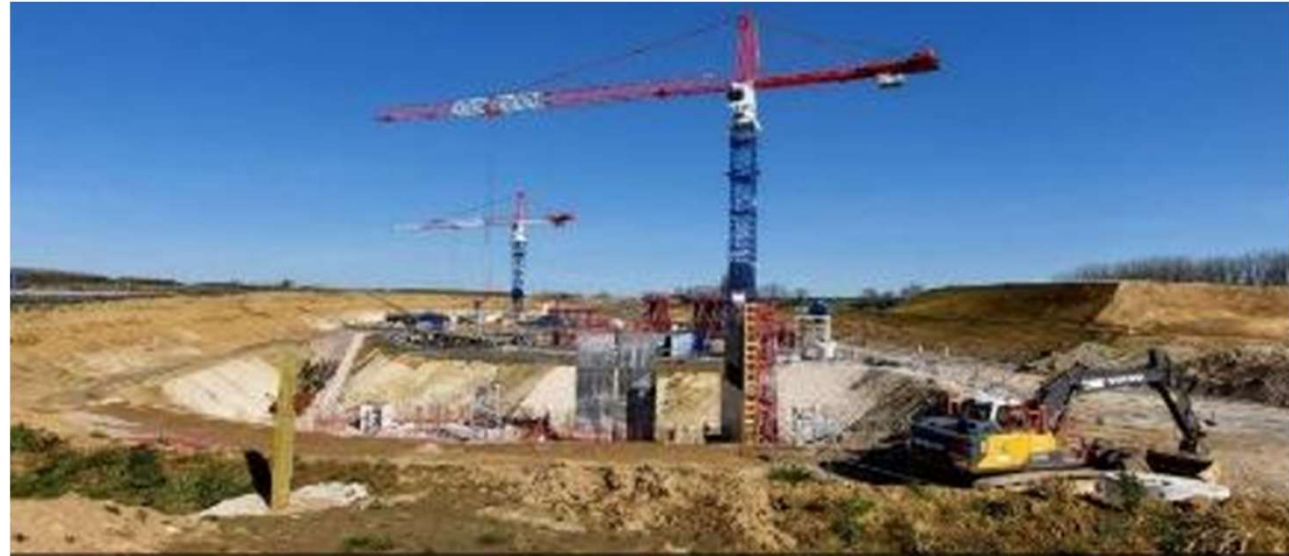
CONSTRUCTION DU PONT SUR L'AUTOROUTE A2 PARIS/BRUXELLES
