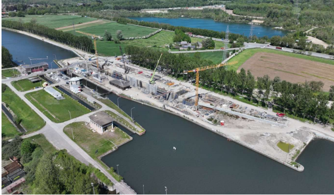
Chantier de la nouvelle écluse d'Obourg (Wallonie)
