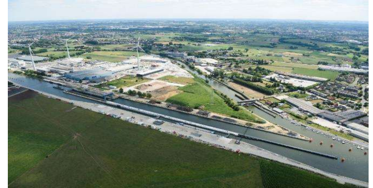
Chantier de la nouvelle écluse de Vive-Saint-Bavon (2023 – crédits : @DVW)
