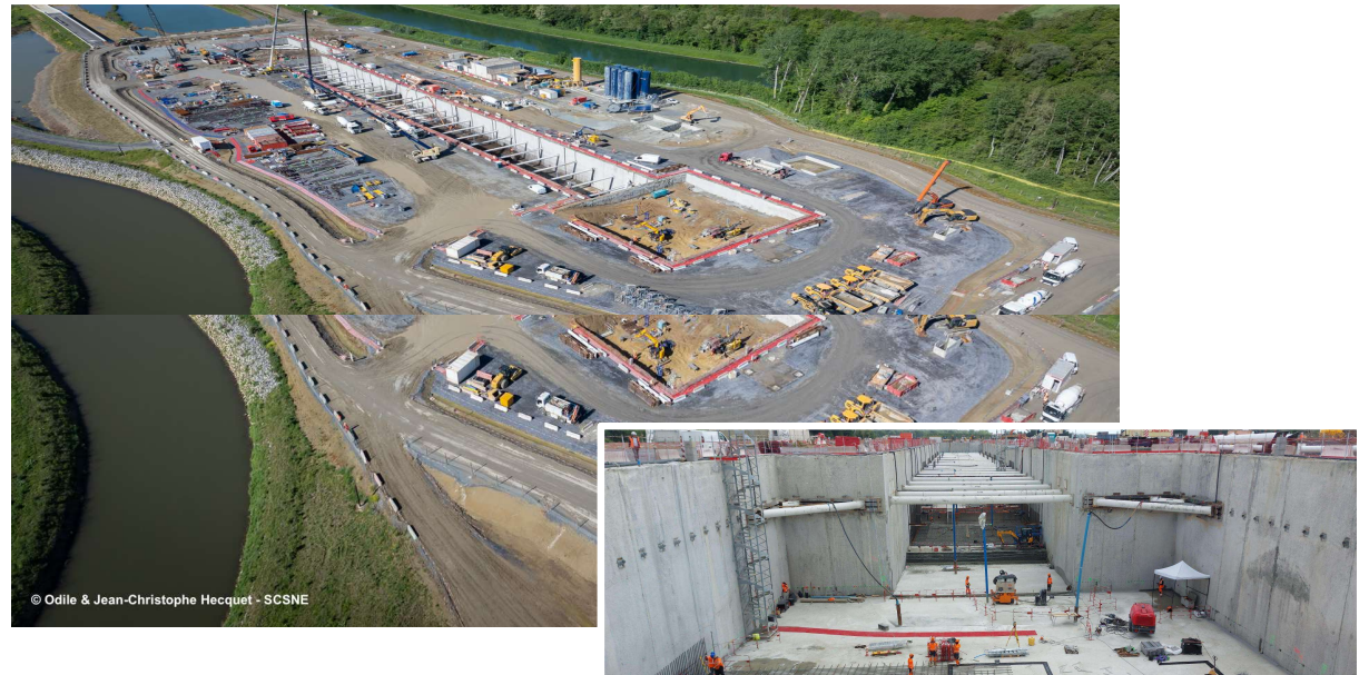
PREMIÈRE ÉCLUSE – CONSTRUCTION EN COURS
