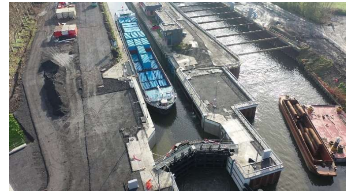
Vue de l'écluse de Quesnoy-sur-Deûle, Décembre 2025
