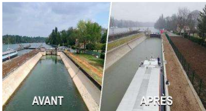
Modernisation of the secondary lock La Cave (Seine) (2023 – crédits : @JVNF)
