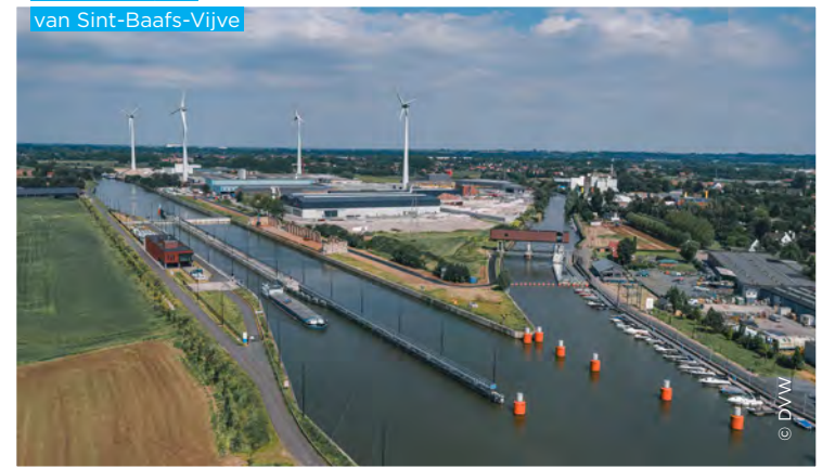
Sluizencomplex van Sint-Baafs-Vijve
