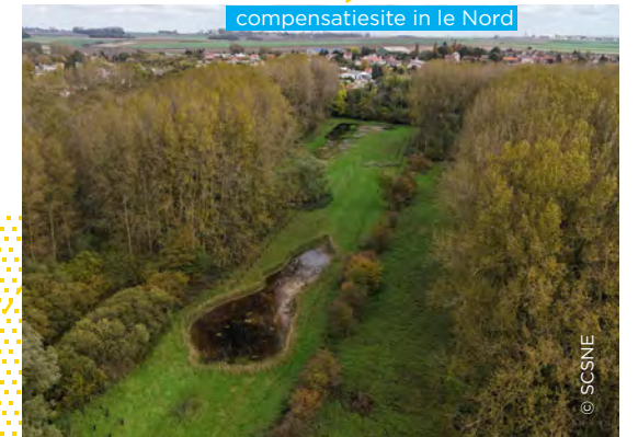
Bouw van een vijver op een compensatiesite in le Nord
