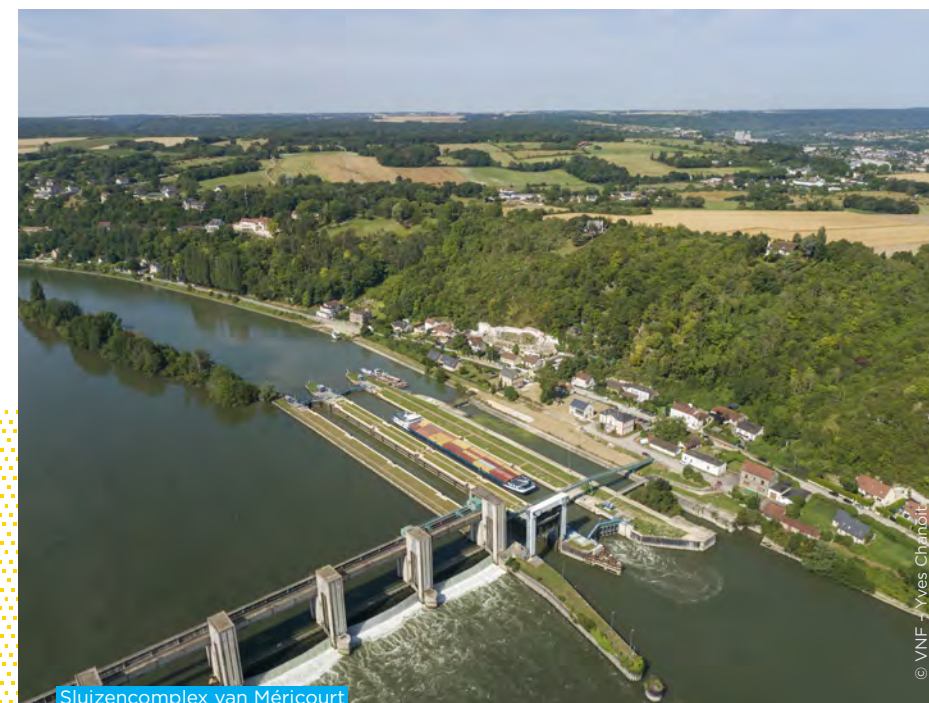
Sluizencomplex van Méricourt
