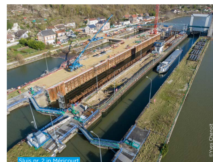
Sluis nr. 2 in Méricourt werd gerenoveerd
