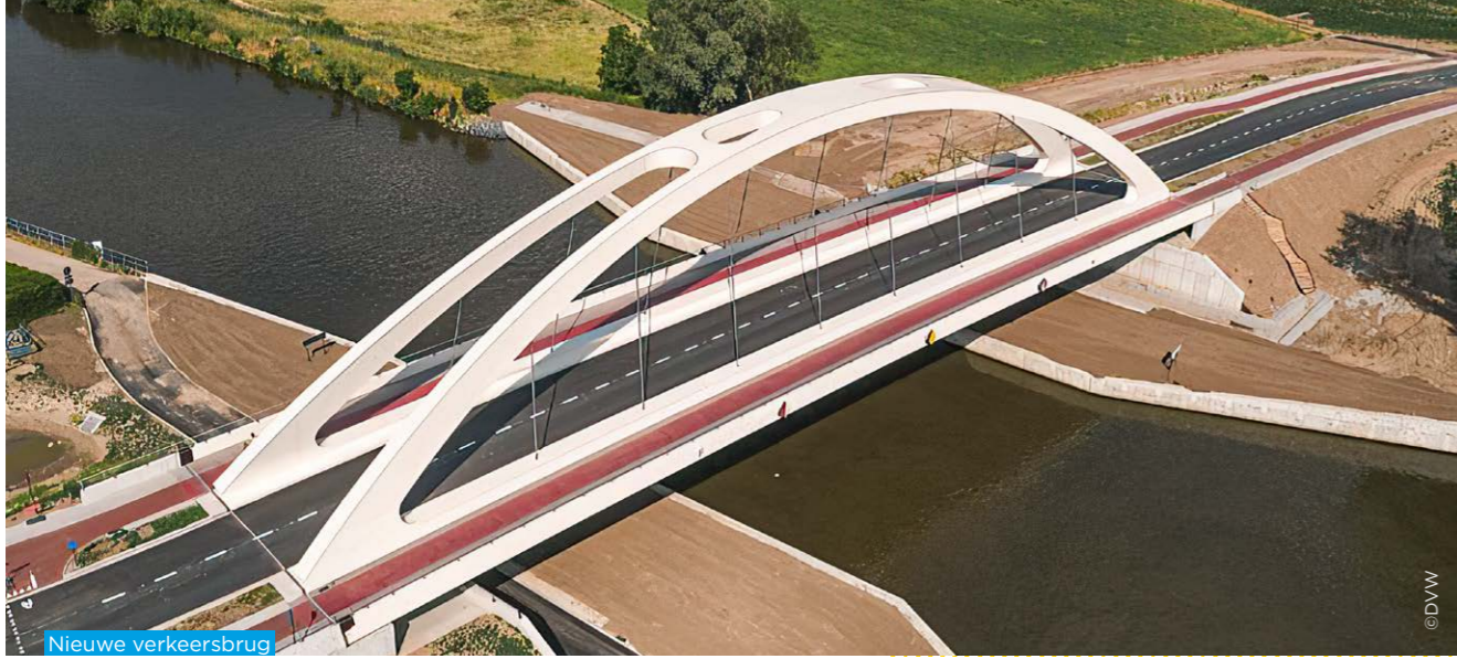
Nieuwe verkeersbrug tussen Bissegem en Marke
