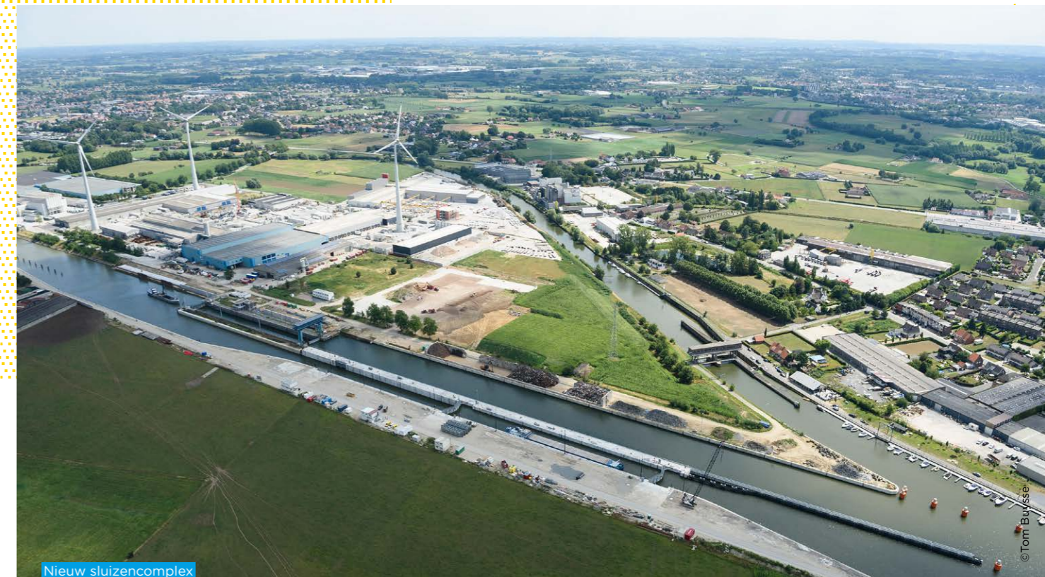
Nieuw sluisencomplex in Sint-Baafs-Vijve
