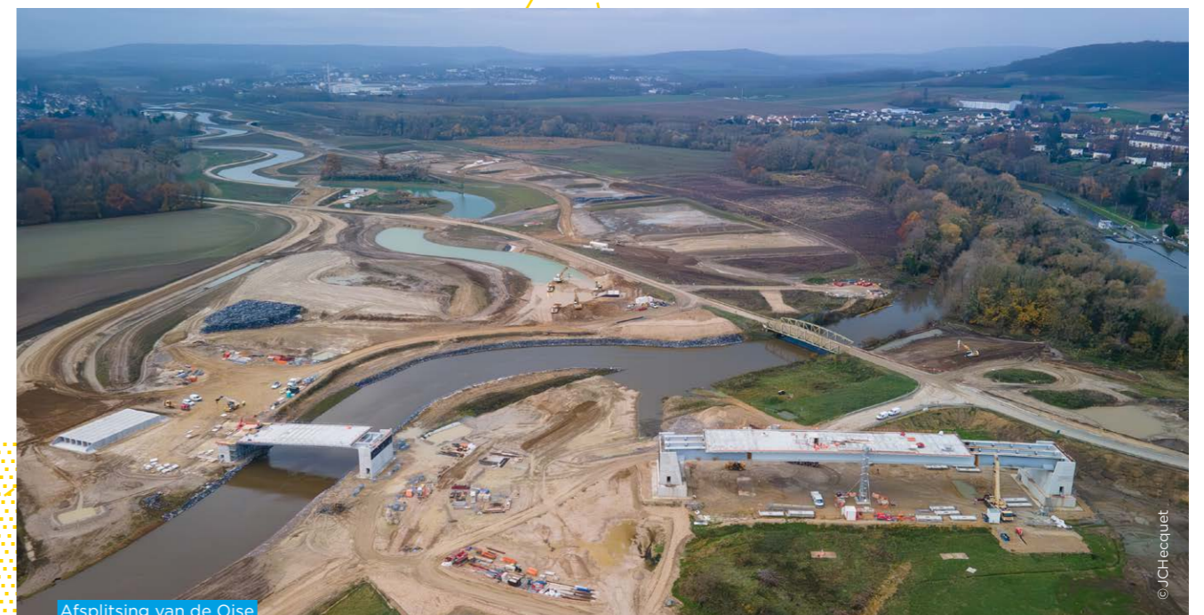
Afsplitsing van de Oise en de bouw van de eerste bruggen
