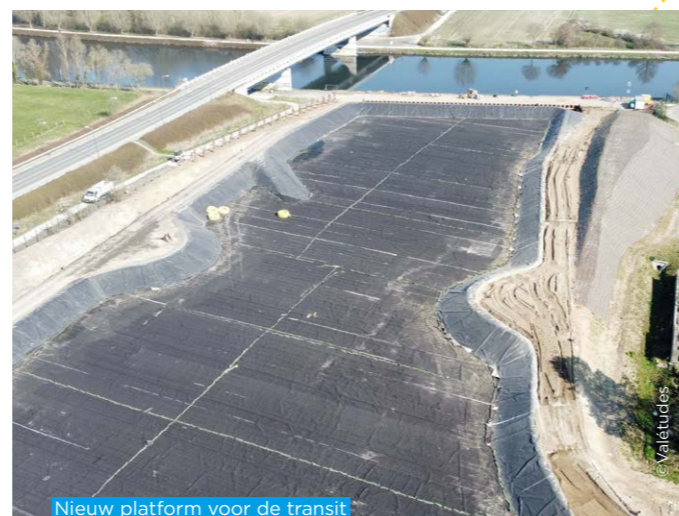
Nieuw platform voor de transit en het drogen van slib in Wambrechies
