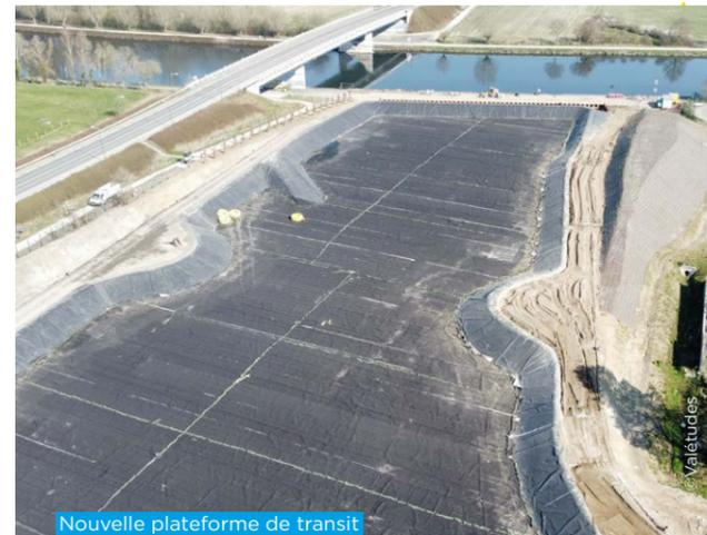
Nouvelle plateforme de transit et de séchage de sédiments à Wambrechies
