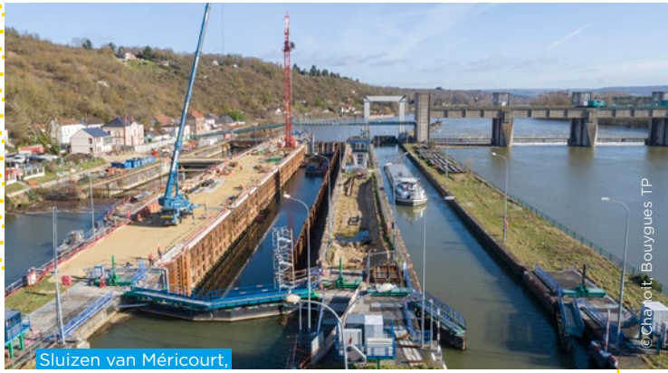
Sluizen van Méricourt, Seinebekken
