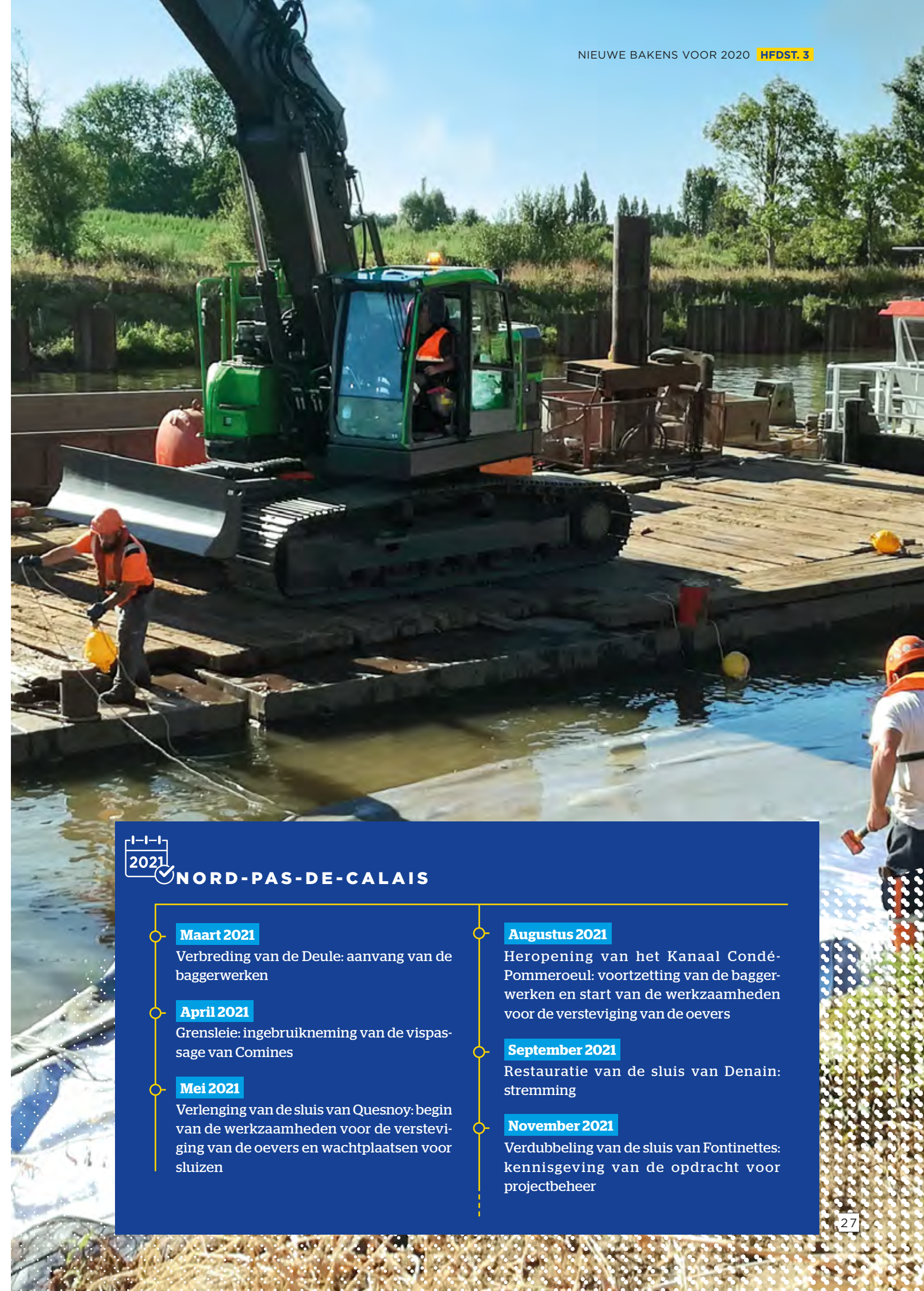
Verbreiding van de Leie - Verankering van geotextiel op taluds vooraleer stortsteen wordt aangebracht © VNF
